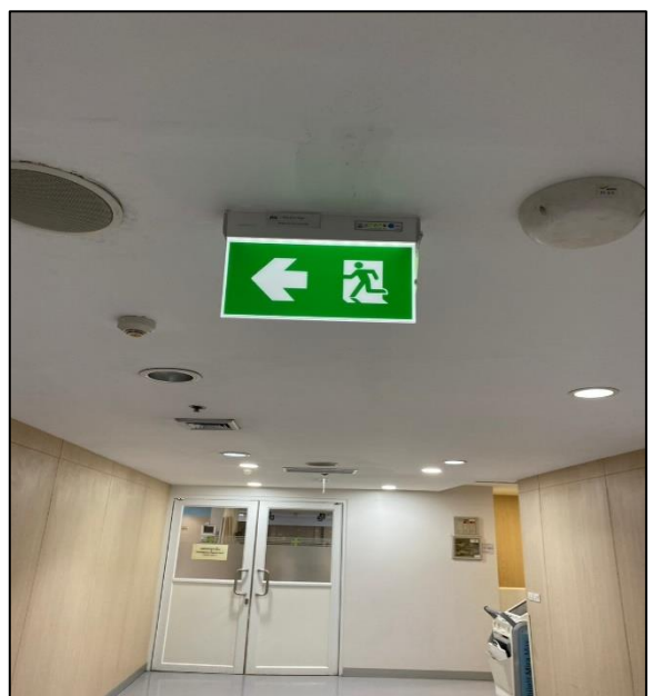
รูปที่ 2.2-14 ระบบป้องกันและแจ้งเตือนอัคคีภัยของโครงการ
